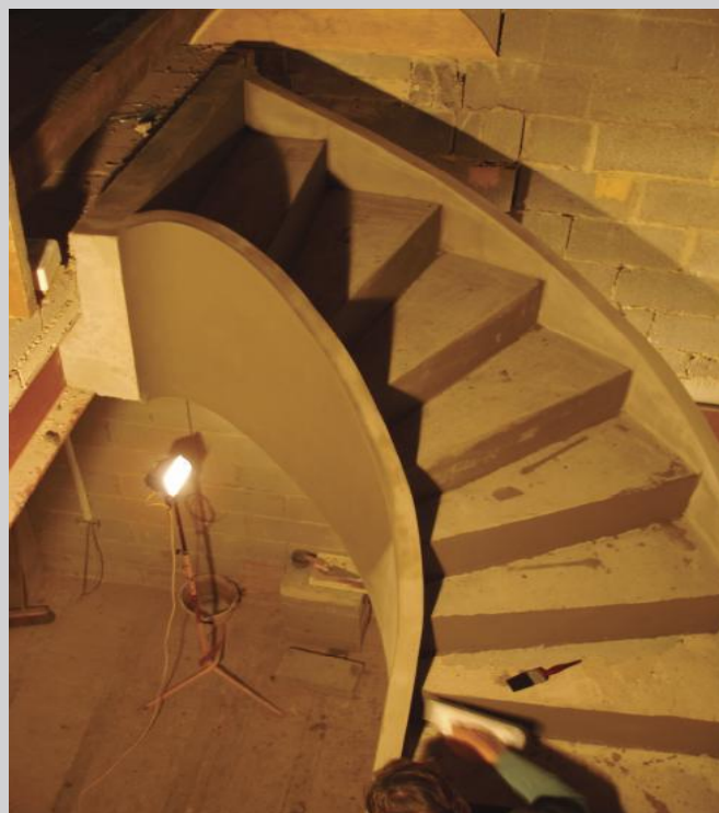
Oprava prefabrikátu schodiště s ARDEX B 14
