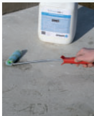
Plochy pro izolaci a oblast soklů jsou opatřeny primerem DiProtec® PR-ZE.
