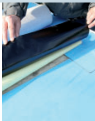
V případě lepení k podkladu se samolepící pás otočí, odstraní se silikonovaný papír a pásy se nalepí s min. 10 cm přesahy.
