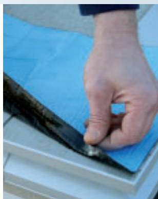
Izolační páska DiProtec® KSK-AB, vybavena oboustranným silikonovaným papírem se nalepí na profilové rameno.
