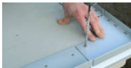
Profily Watec® DP jsou upevňovány pomocí montážního setu se šroubky z ušlechtilé oceli, dodávaným jako součást balení.
