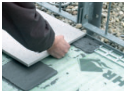
Drenážní ukončovací profil TerraMaxx® 22 je zafixován spolu s přední řadou dlažby na drenážní rohoži AquaDrain® T+. Chrání okraj dlažby a tvoří čisté ukončení balkónu.
