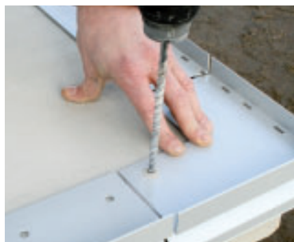
Ukončovací profily WatecFin® FA-11 se vyrovnávají a pak se upevní pomocí montážního setu, dodávaným spolu s profily.
