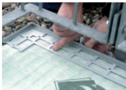
Drenážní ukončovací profil TerraMaxx® 22 je zafixován spolu s přední řadou dlažby na drenážní rohoži AquaDrain® T+. Chrání okraj dlažby a tvoří čisté ukončení balkónu.
