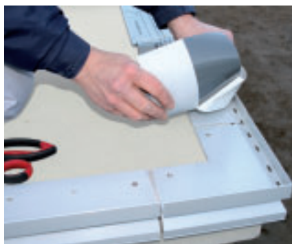
Samolepící izolační páska DiProtec® AB-V se nalepí na profil a podklad. Pak následuje nalepení dlažby do minerální izolace.
