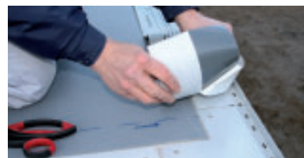
...a pomocí samolepících izolačních pásek DiProtec® Ab-K jsou rychle a jednoduše napojeny na profily Watec® DP.
