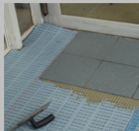
3. přilepíme dlažbu a vyspárujeme s ARDEX FL
