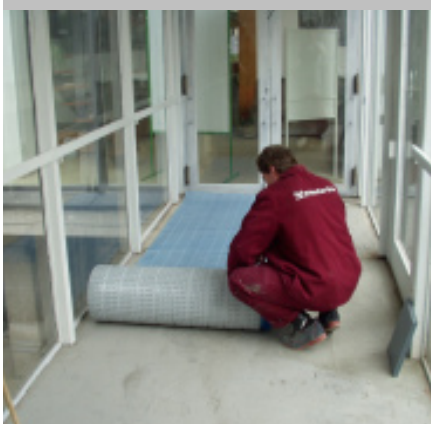
1. rohož rozvineme na vyrovnaný podklad (bez lepení)
