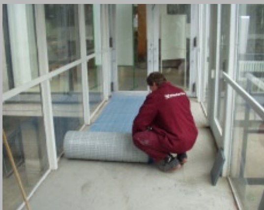
1. rohož rozvineme na vyrovný podklad
