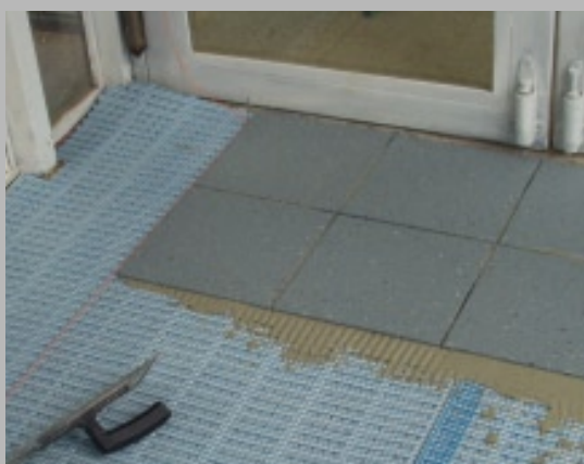
3. přilepíme dlažbu a vyspárujeme s ARDEX FL
